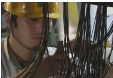
圖39：線端接pin壓接
