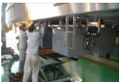
圖48：車下大型設備安裝
