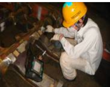
圖54：非破壞性焊道檢驗
