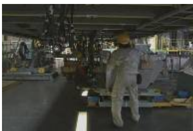
圖47：車下大型設備安裝
