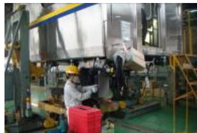
圖40：高低壓接線箱安裝
