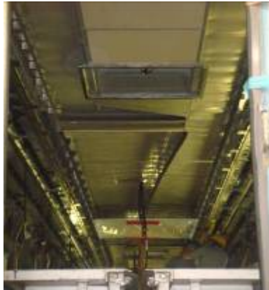
圖42：風道與燈具支架安裝
