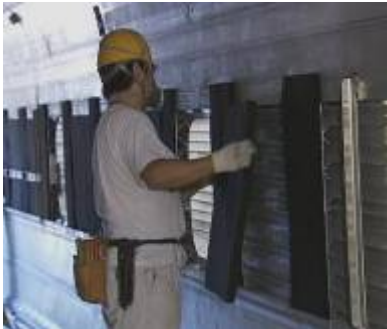
圖24：車內安裝隔熱材
