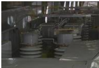
圖66：高壓系統耐壓檢查
