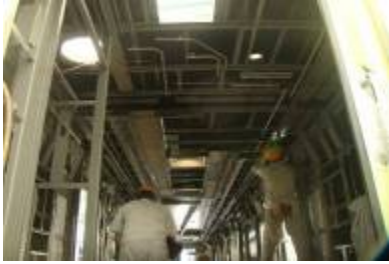
圖32：管路固定衍架焊接
