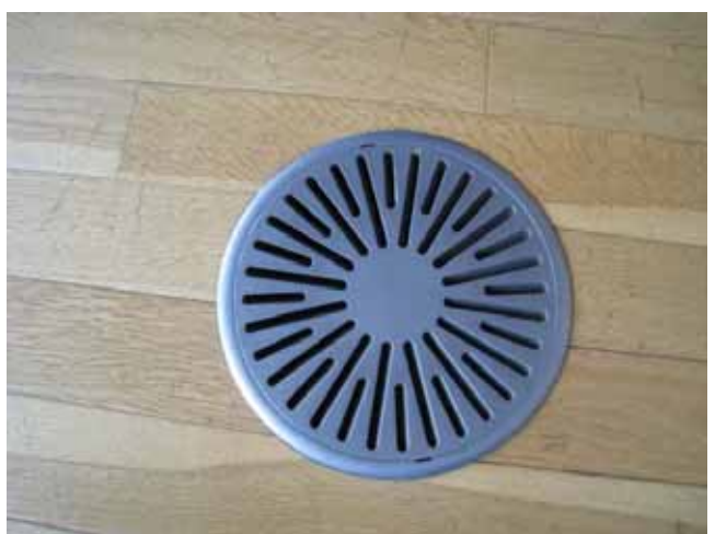
樓上走道的櫟木地板設置許多小通風口，是建築師利用地下自然換氣的巧思設計。
