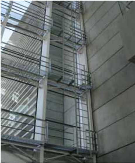
大片的玻璃帷幕牆，設有走道與安全梯供清潔人員上下。
