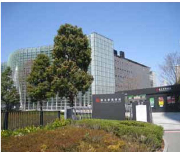
外牆為全面波浪造型玻璃帷幕的國立新美術館。
