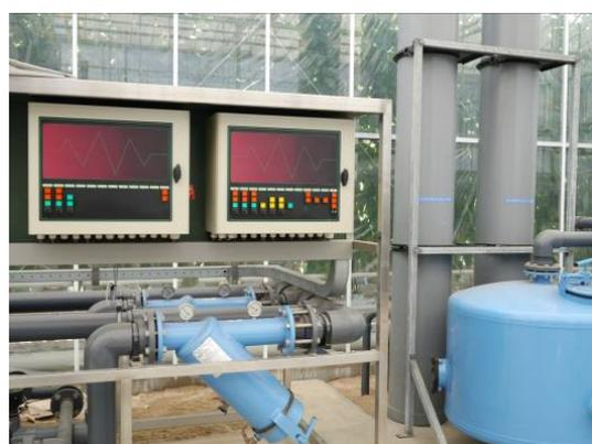
圖 56、水耕養液回收及監測系統
