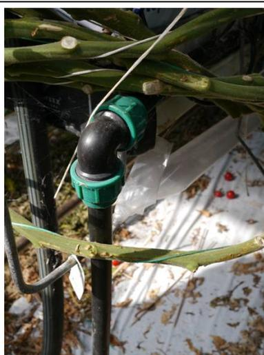
圖 55、床架下之二氧化碳塑膠管路
