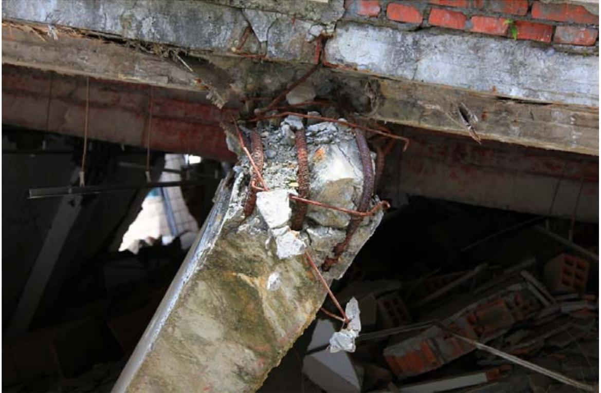
圖 37 細如絲的箍筋，柱頭毫無抵抗力。混凝土樓版下方多了一層不知名的異物。
