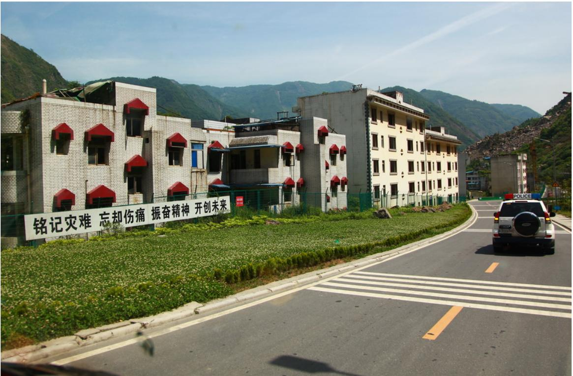
圖 30 此道路開設在震後土石流堆積物之上，左側房屋下半部還埋在土堆中
