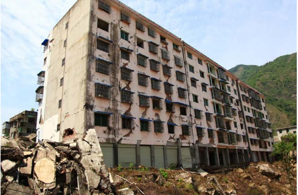
圖 43 難得沒有重大結構損傷的樓房
