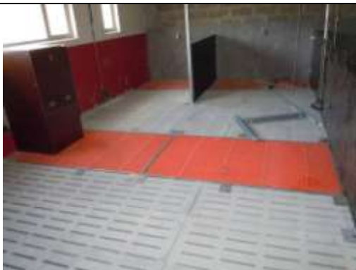
建構中的欄舍採用模組化的欄架與板材組裝而成
