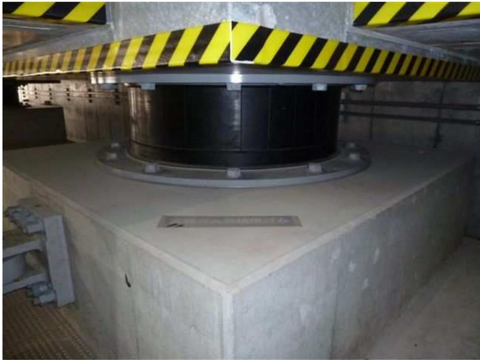
圖 7-10、浜岡核電廠免震建物基座
