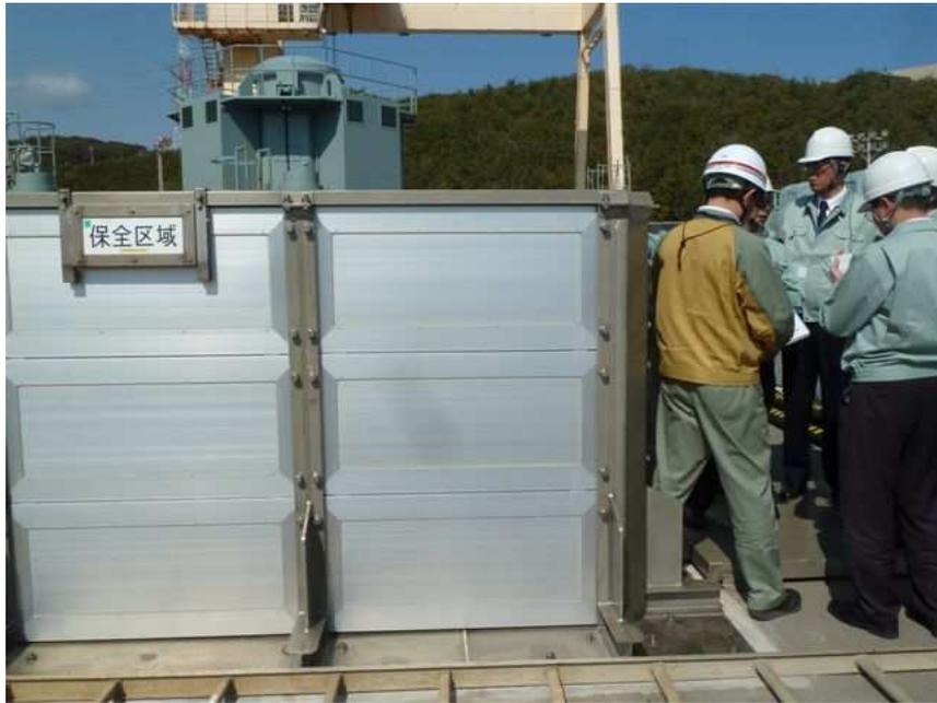
圖 7-2、浜岡核電廠海水泵安裝 1.5m 防水牆
