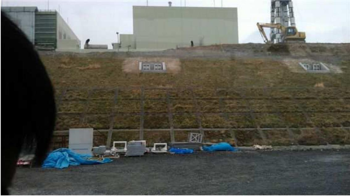
圖 3-2、女川核電廠防海嘯海堤強化工程施工情形
