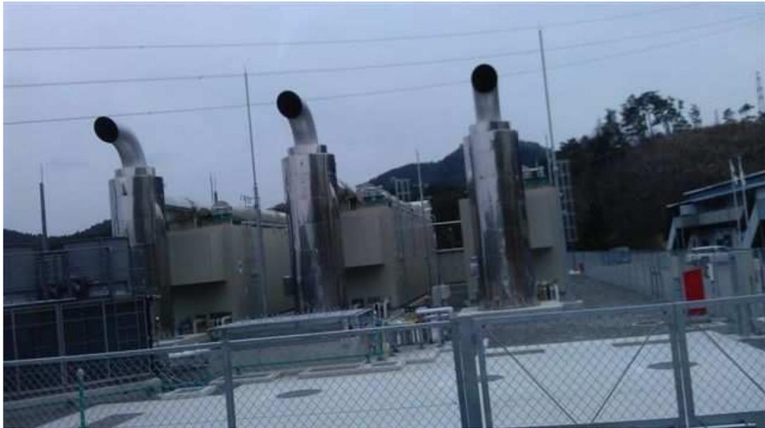
圖 3-3、女川核電廠因應島事件後裝設之大容量電源設備
