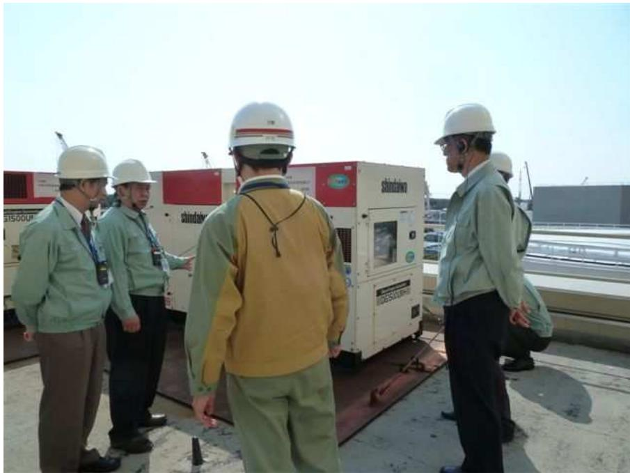
圖 7-5、浜岡核電廠反應器廠房屋頂增設緊急發電機
