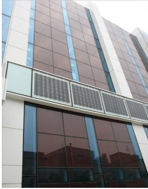
圖 4.9-2 NIER 氣候變遷館外牆由太陽能板覆蓋
