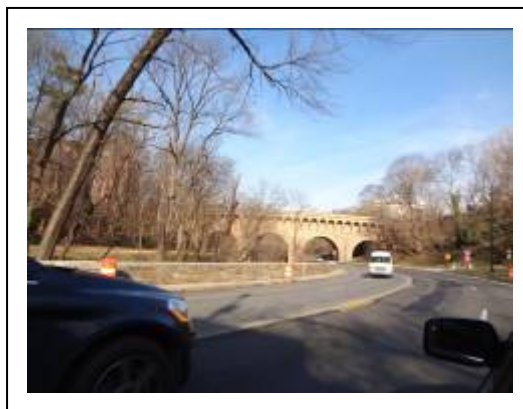
圖 5-4 華盛頓 DC 地區拱橋(2)
