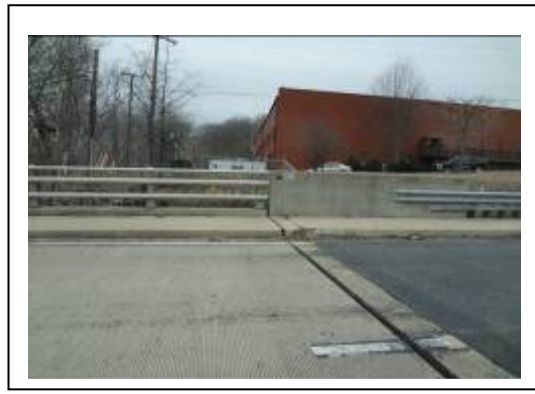
圖 5-2 橋梁路段採剛性路面(2)
