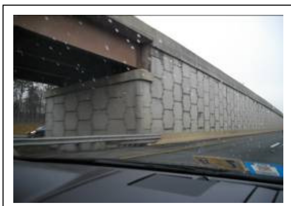
圖 5-5 預鑄面版加勁式擋土牆(1)
