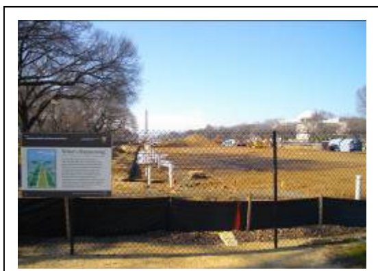
圖 5-7 工程圍籬上掛有工程告示牌
