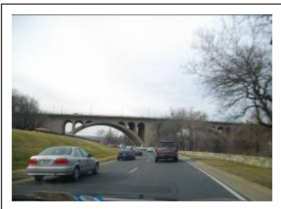
圖 5-3 華盛頓 DC 地區拱橋(1)
