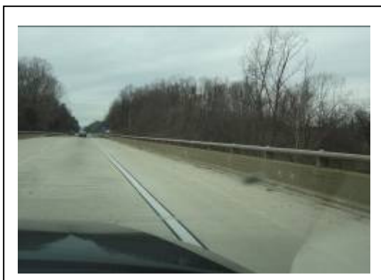
圖 5-1 橋梁路段採剛性路面(1)
