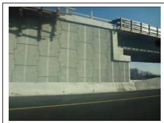
圖 5-6 預鑄面版加勁式擋土牆(2)
