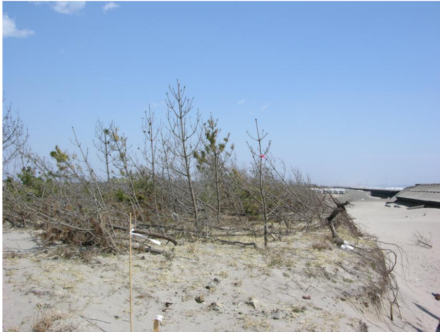
圖6 仙台市荒濱海岸防潮堤破損及林木被害
