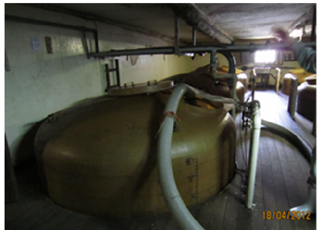
製麴完畢加入鹽水下缸貯存，貯存醬油醪用的釀造桶容量有 80 公噸
