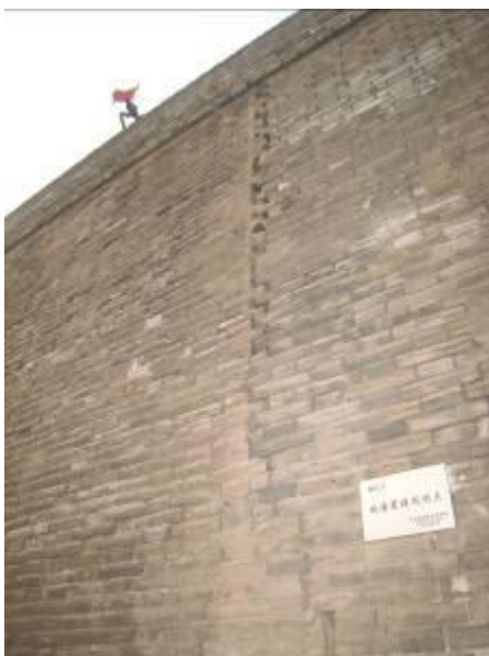
◀西安古城城牆文物「保護巡查制度」，城牆牆體外側重點觀測部位 26 處，安裝了觀測標誌碑，確定了觀測點和觀測基準數。
