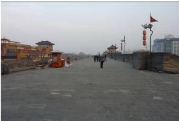
▲西安城牆牆頂面，牆頂頂面略微斜面，當時作為蓄水儲水引流功能，面寬可以跑車和操練。
