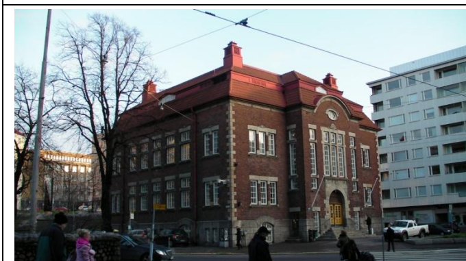
圖 9. 赫爾辛基市立圖書館 Kallio 分館
