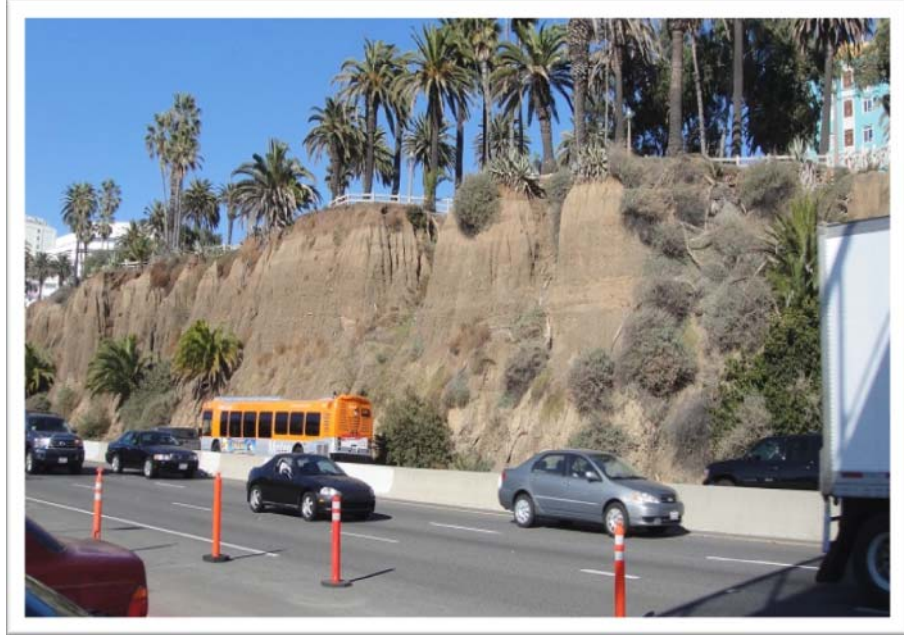
圖二十四 Santa Monica 公路邊坡
