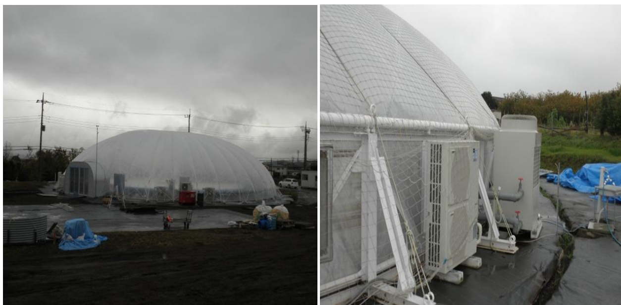
圓頂型太陽光利用型植物工廠外觀與其架設方式
