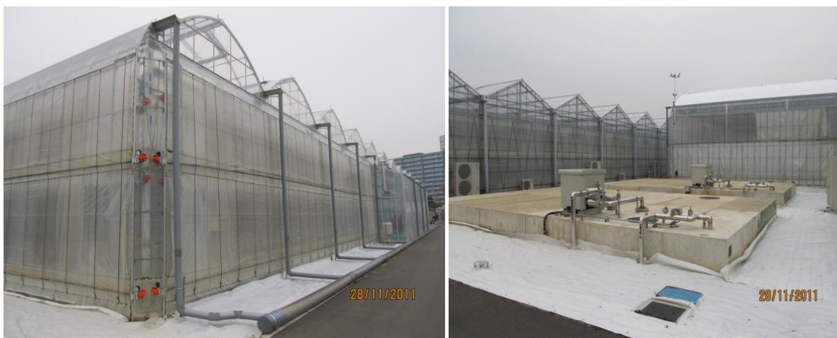
設置有雨水收集系統之太陽光利用型植物工廠
