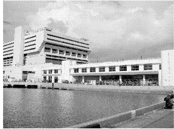
圖 6：新加坡郵輪中心「港濱郵輪碼頭」海側
