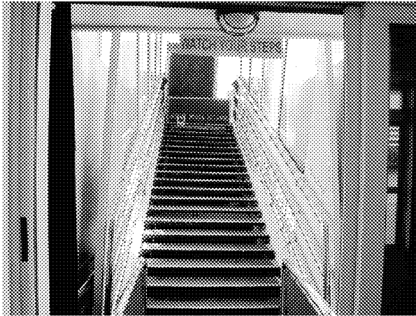
圖 15：階梯式旅客橋橋箱通道
