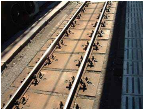
照片 3-81 E 型鋪裝軌道
