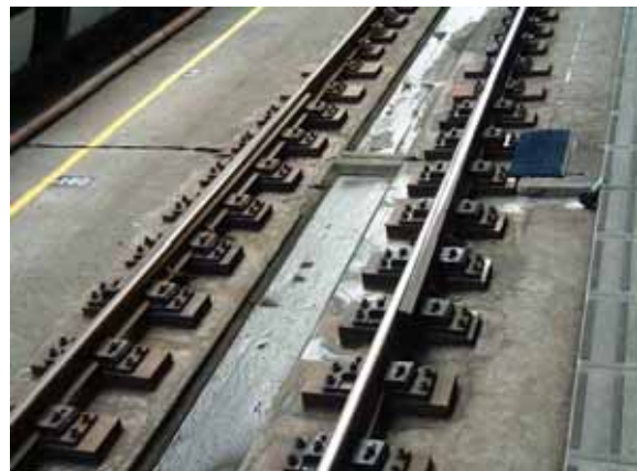
照片 3-80 合成枕木省力化軌道 EJ
