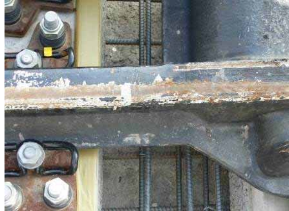
照片 3-72 高雄捷運錳鋼岔心過渡段
