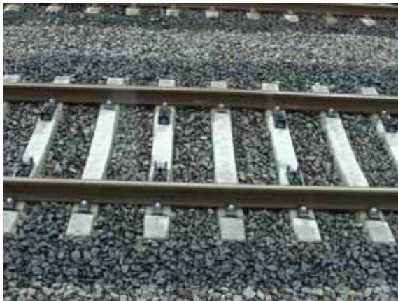
照片 3-86 安裝固定金具
