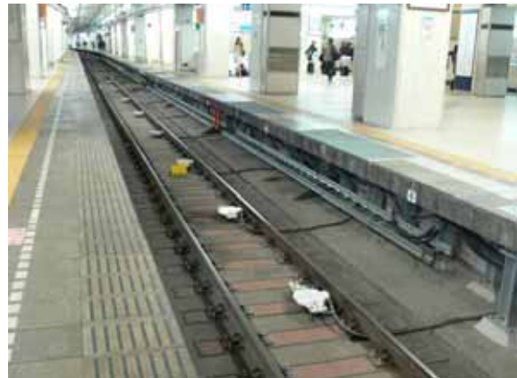
照片 3-84 小田急合成枕木直結軌道
