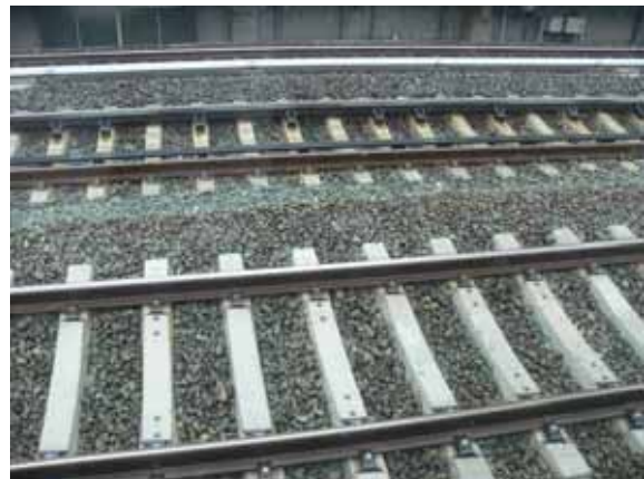
照片 3-85 預留安裝孔枕木
