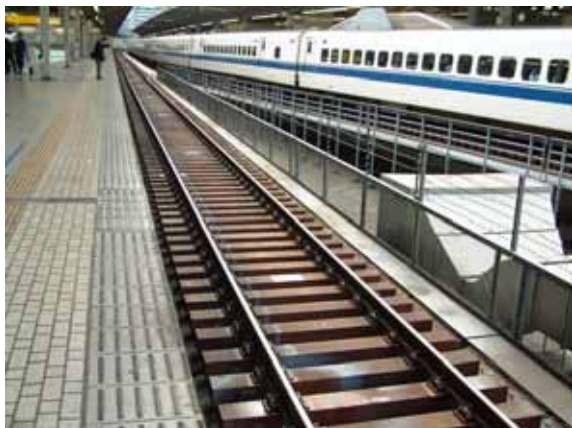
照片 3-79 合成枕木橋枕
