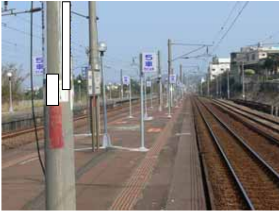
照片 3-67 柱桿林立的月台
