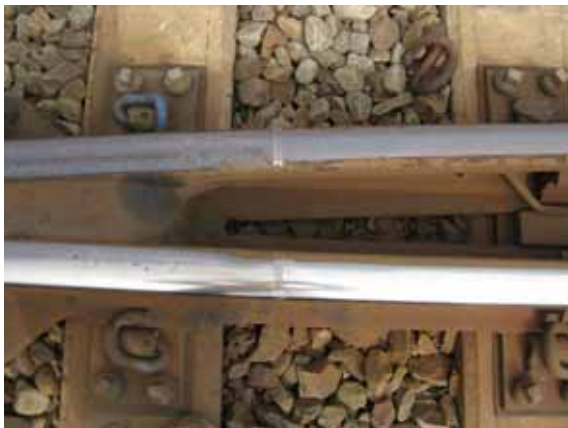
照片 3-73 本局 UIC60 錳鋼岔心過渡段
