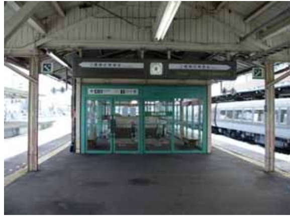
照片 2-44 玻璃隔離門
