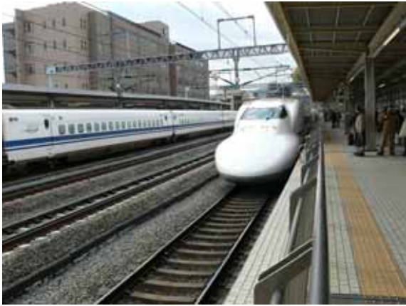
照片 2-83 固定式月台柵欄
