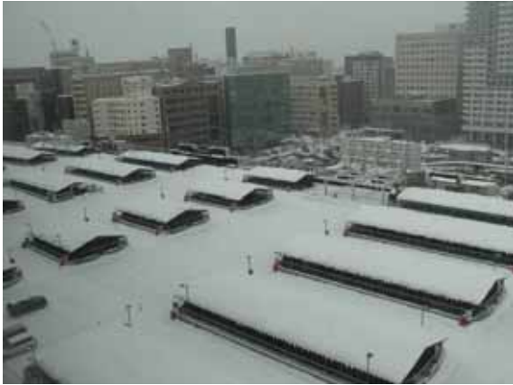
照片 2-13 跨站人工地盤停車場
