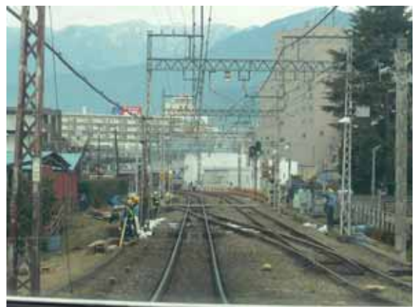
照片 2-74 道岔前伸縮接頭 (EJ)
