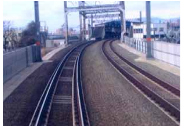
照片 2-72 有碴縱枕軌道
