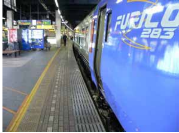
照片 2-26 曲線月台加寬情況
