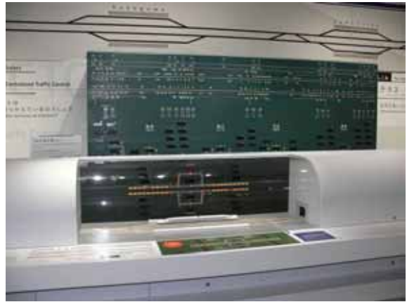
照片 2-130 電務-行車控制運作
