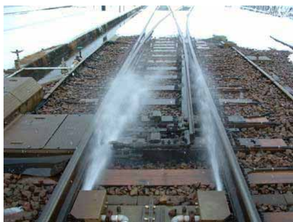
照片 2-101 轉轍器溫水噴射裝置
