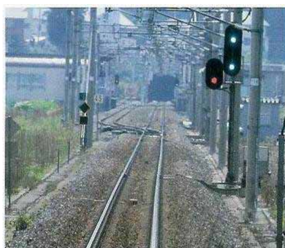
照片 2-99 一線直通形（號誌站）
