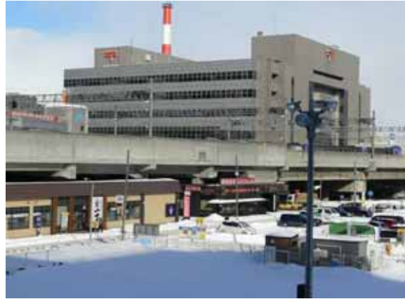
照片 2-14 鐵路高架橋下空間商業利用
