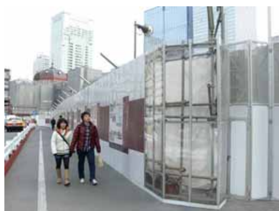
照片 2-53 丸之內站房復舊工程周邊安全防護
