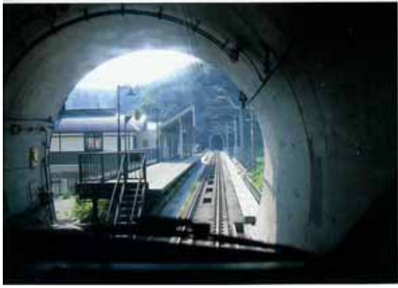
照片 2-96 與九州新幹線相同的框形版式軌道
