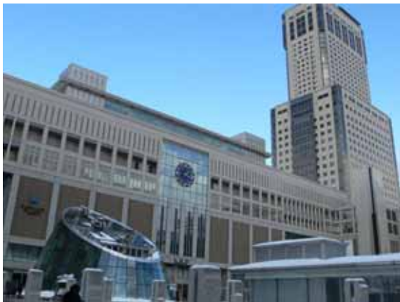
照片 2-11 札幌車站與商辦大樓共構
