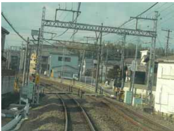
照片 2-75 電纜槽配置
