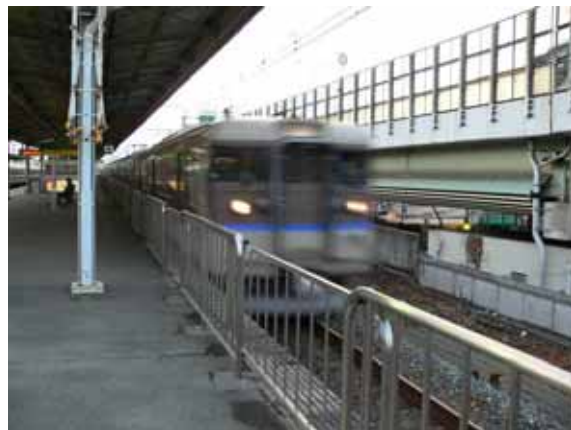
照片 2-143 通過線月台柵欄
