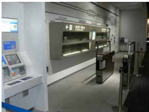
照片 2-122 運務閘門系統
