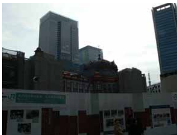
照片 2-52 復舊工程進行中的丸之內車站
