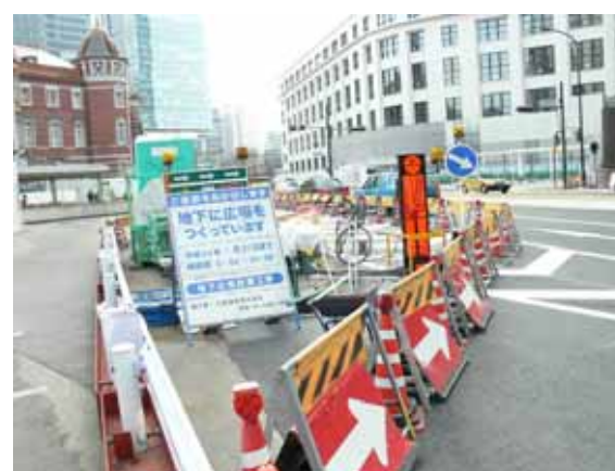
照片 2-54 丸之內站地下廣場設置工程
