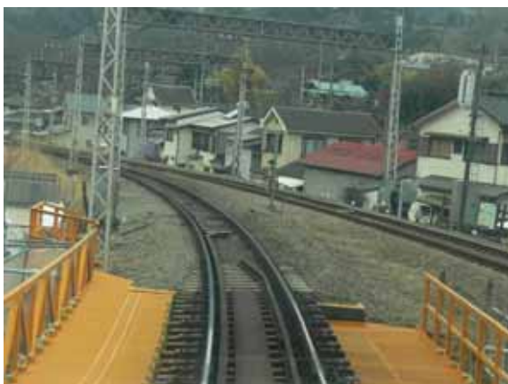
照片 2-73 鋼樑橋合成枕木及護軌
