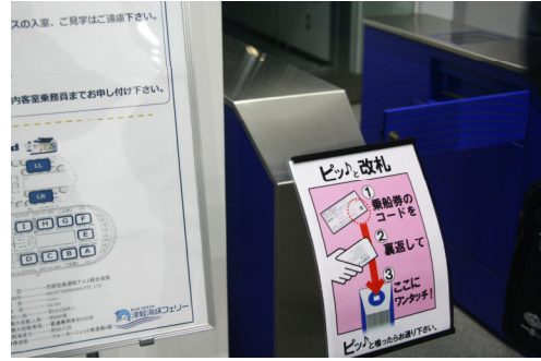
圖 68 高速船登船閘道自動票閘
