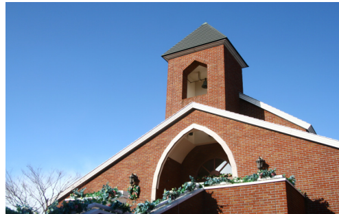
圖 88 金森倉庫建築物
