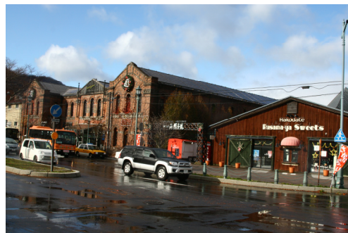
圖 86 金森倉庫臨市區道路側
