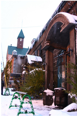
圖 104 小樽運河倉庫
