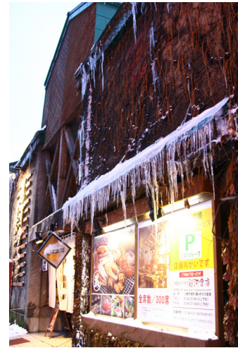
圖 106 小樽運河倉庫
