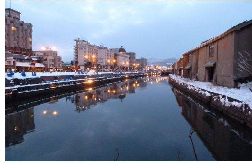
圖 112 小樽運河倉庫
