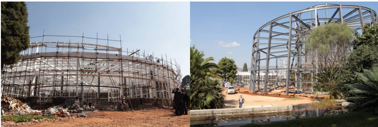
扶荔宮施工一景
