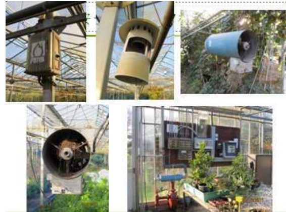
圖 22 被鳥築巢的廢棄溫室環控系統
