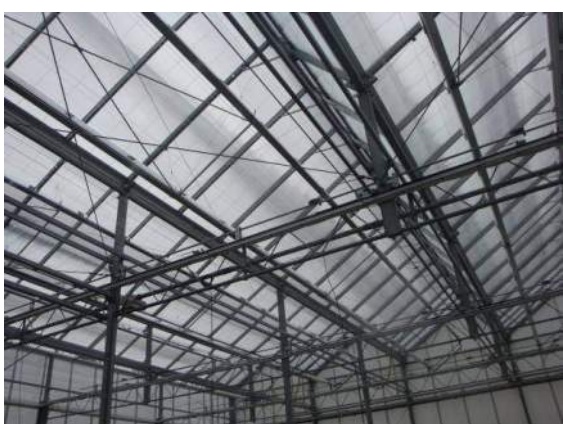
圖 97 Daylight 節能溫室聚光板屋頂結構
