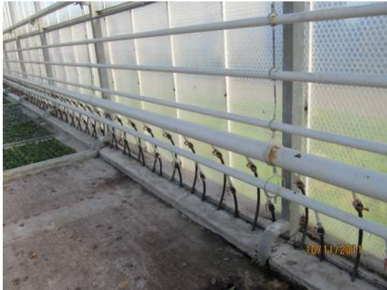
圖 141 埋在水泥板下之加熱管路
