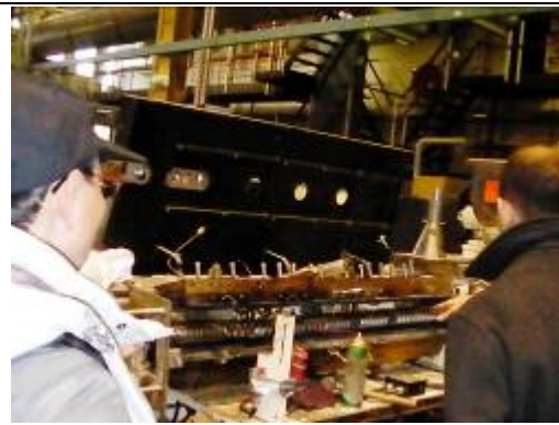
膨化過程的相關控制設備與管線
