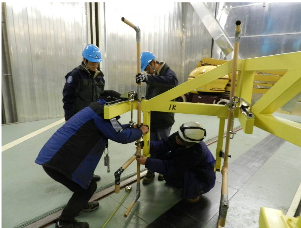
圖 32 本院工作人員與日本工作人員共同安裝濾鏡交換機構模擬框架。
