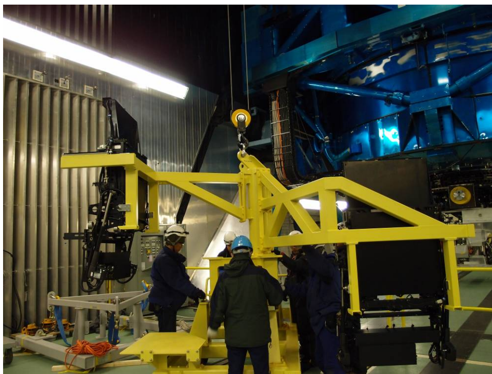
圖 37 本院工作人員協助濾鏡交換機構安裝測試，組裝型架與濾鏡交換機構吊離搬運車。
