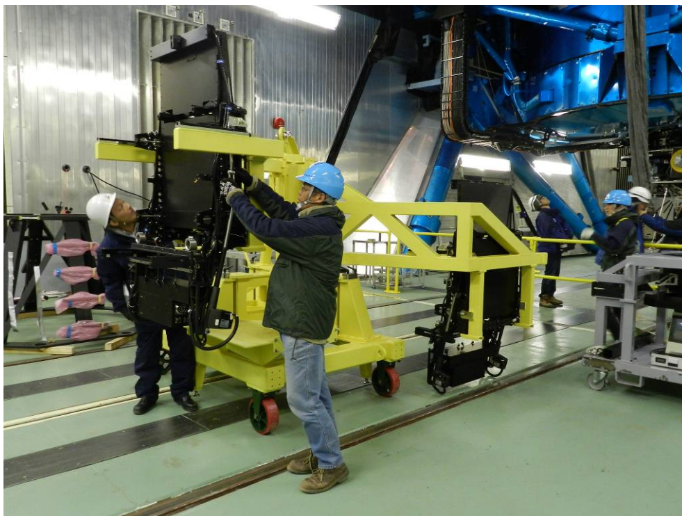
圖 36 本院工作人員協助兩側濾鏡交換機構安裝於組裝型架。
