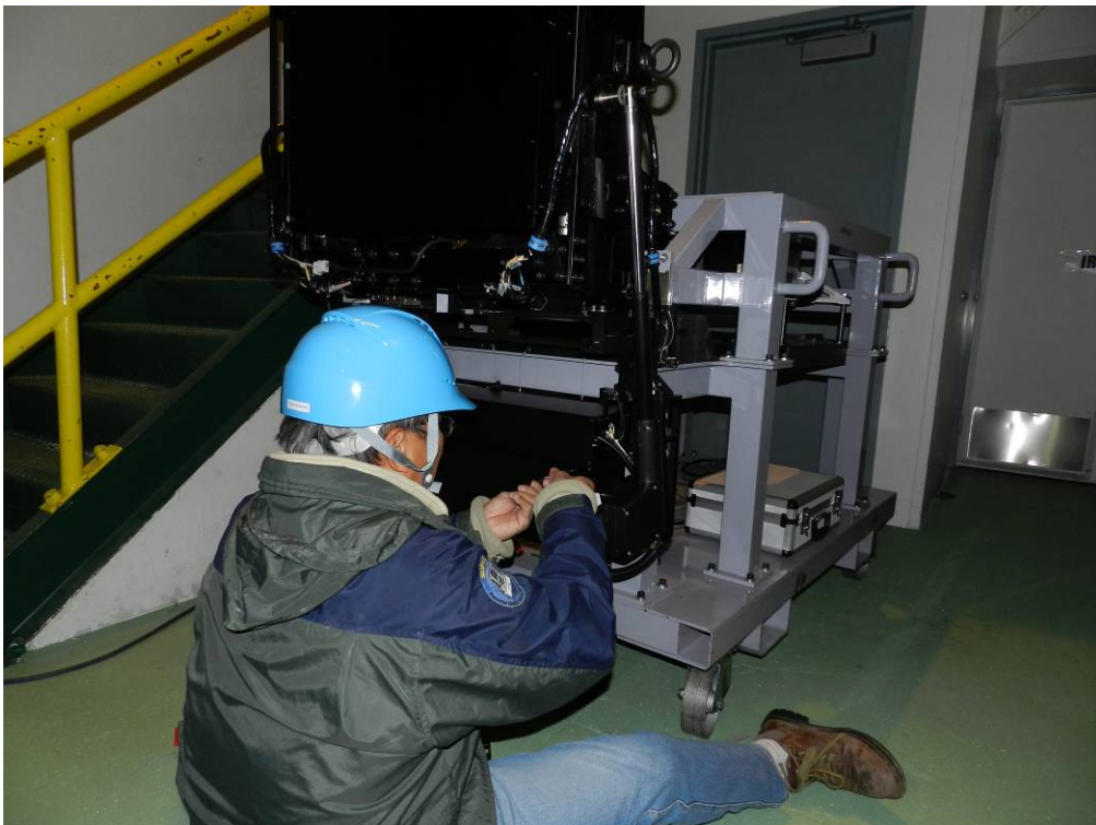
圖 11 本院人員完成濾鏡閘門驅動電路板更換後進行復原。
