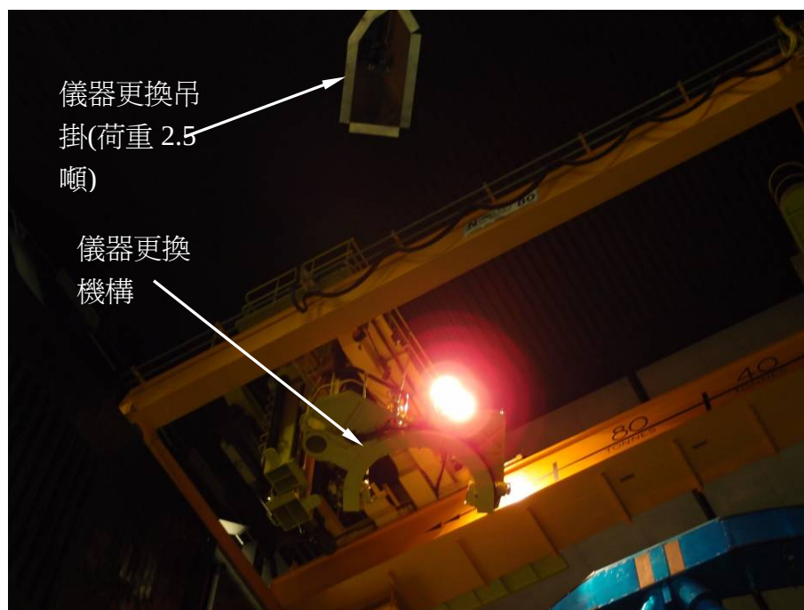
圖 26 速霸陸望遠鏡儀器更換機構位於建築物頂部離地面約 30 公尺。
