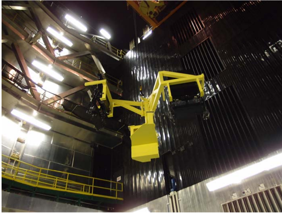
圖 42 濾鏡交換機構實體執行安裝預配完成吊回地面，再安裝回組裝型架搬運車。
