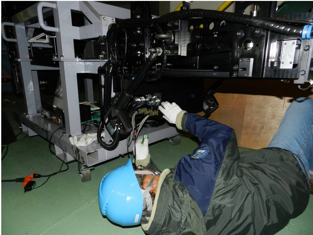
圖 8 本院人員先拆除所有訊號及電力接頭，再更換濾鏡閘門驅動電路板。
