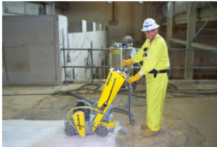
圖七、鑽石地面混凝土刨除機使用經驗
