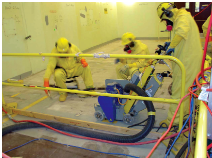
圖九、Rocky Flats 核武工廠刨除地板
