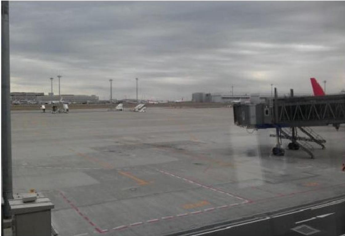
羽田機場停機位畫設兩停止線，未停放飛機時則作為裝備停放區，以提高使用率。
