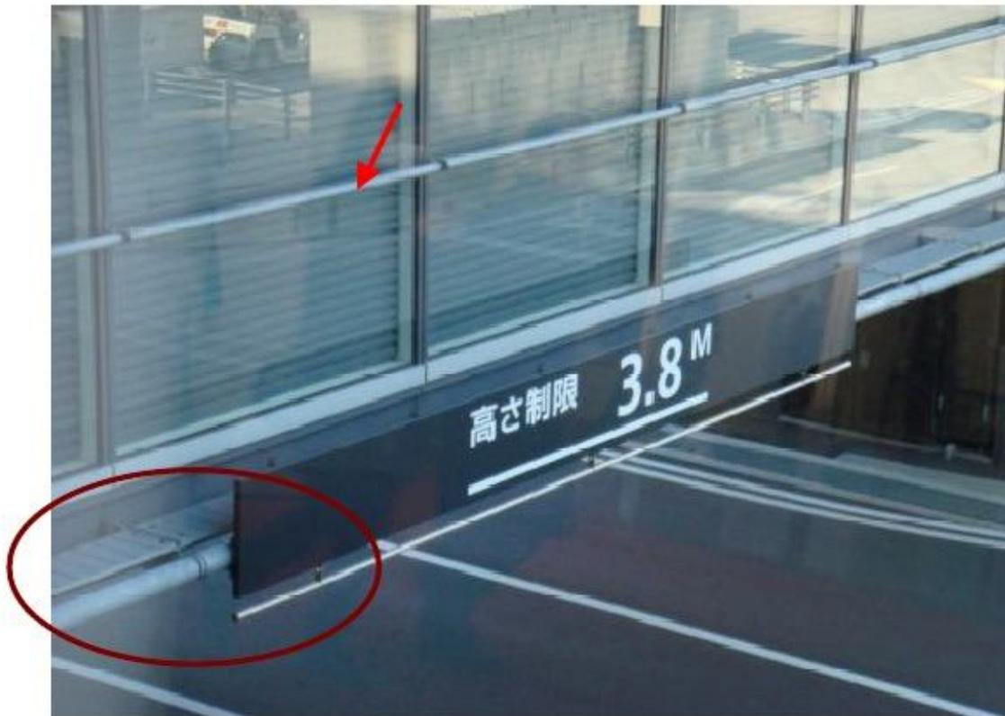
設施設置的巧思併顧後續維護作業所需之安全設備（如人行貓道及安全（母索）扶手設置）。
