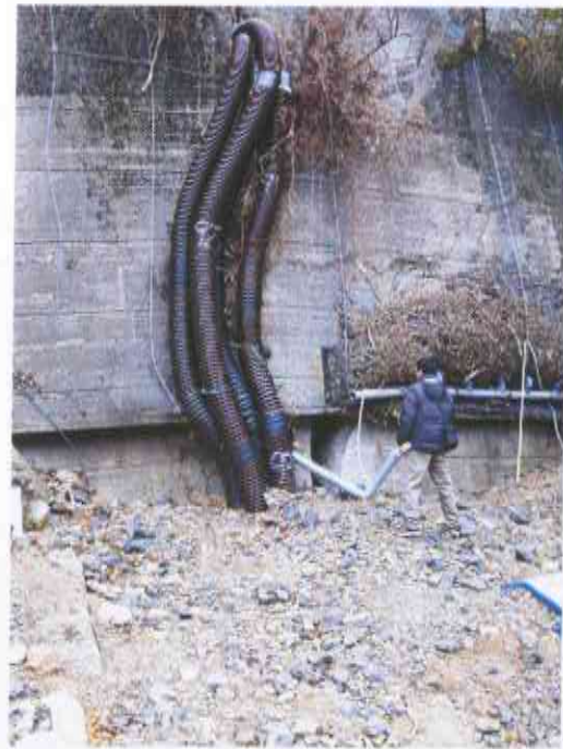
臨時設置之水流引導管線
