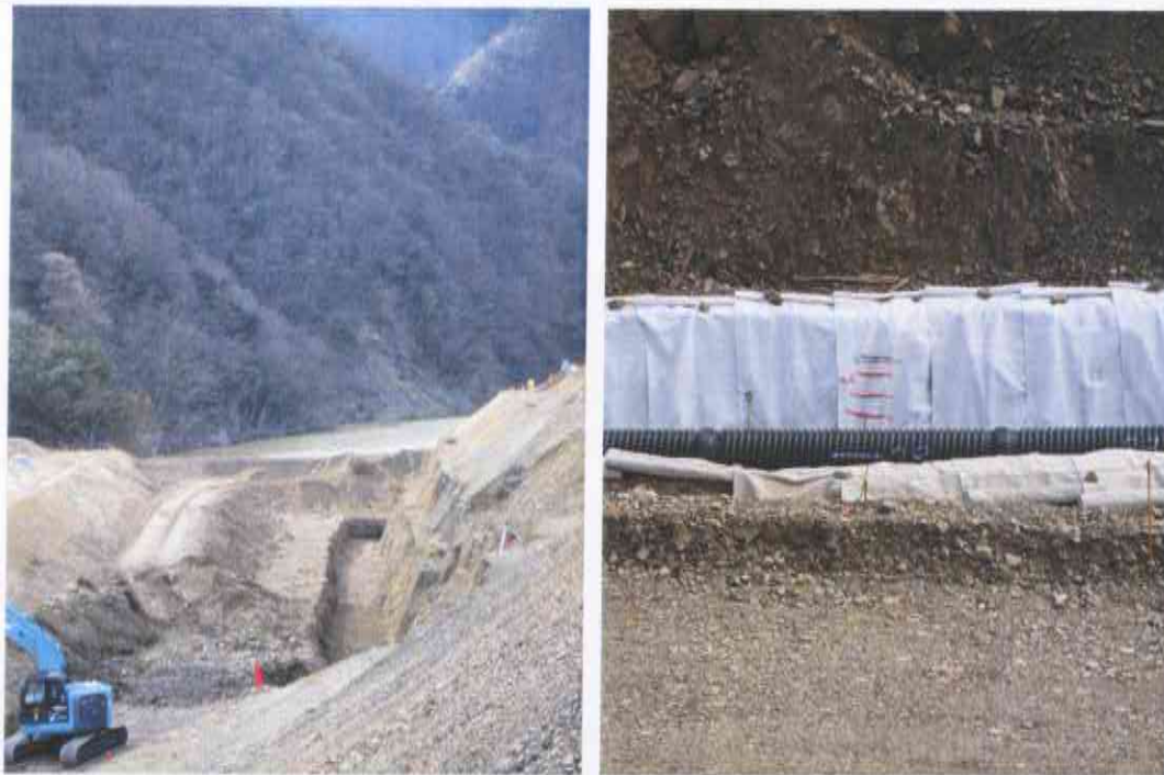
堰塞湖及臨時引流道(採上方明渠，下方暗管方式引流)
