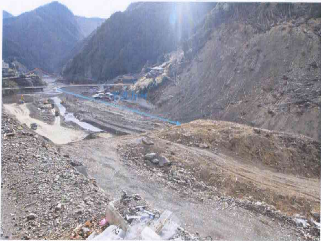
崩塌形成堰塞湖後，積水回淹造成上游住家受災(堰塞湖現已潰決)
