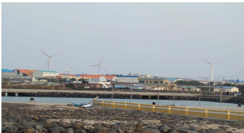
圖 15 濟洲智慧電網測試地點舊左邑地區現況
