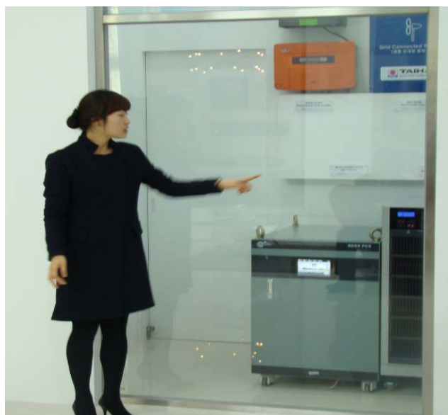
圖 24 智慧住宅中的逆變器與蓄電池
