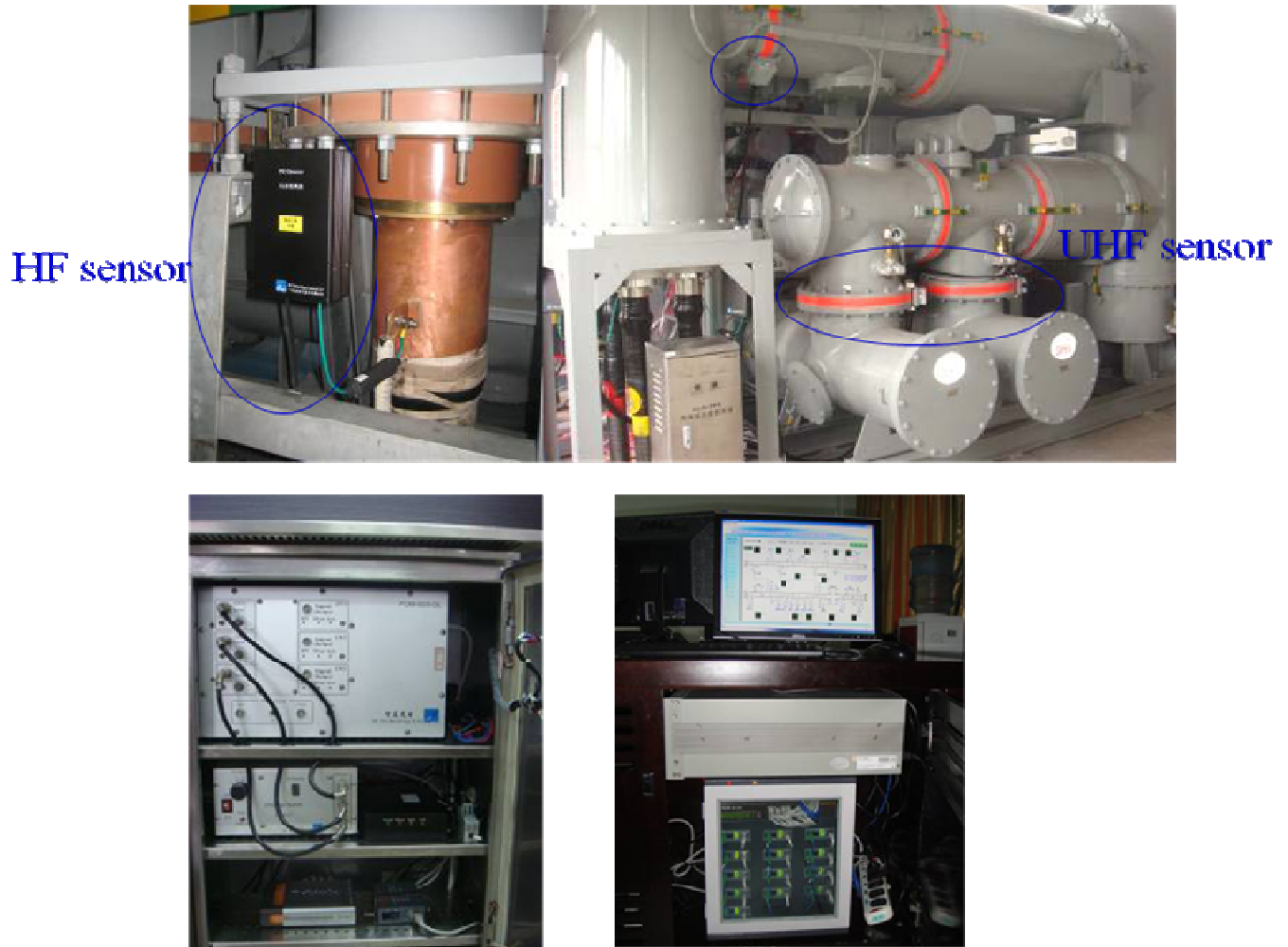
圖9 關西電力於變電所 GIS 型電纜終端匣的系統組合量測系統
