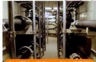
SIJ (陸上と海底ケーブルの接続箱)
