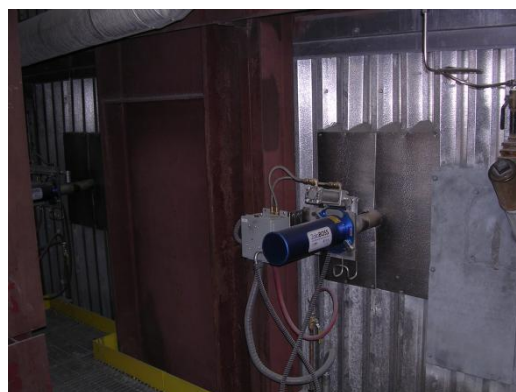
照片 4-5 現場偵測器安裝(前爐)
