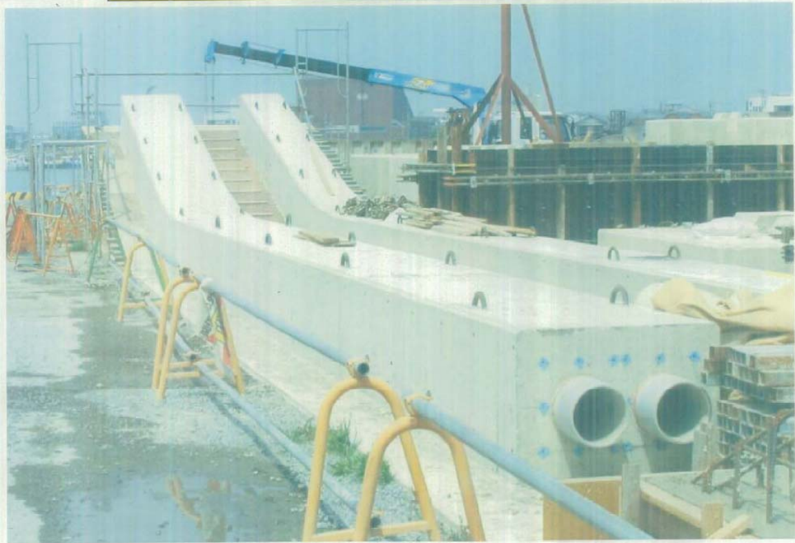
預鑄混凝土節塊防護工法
