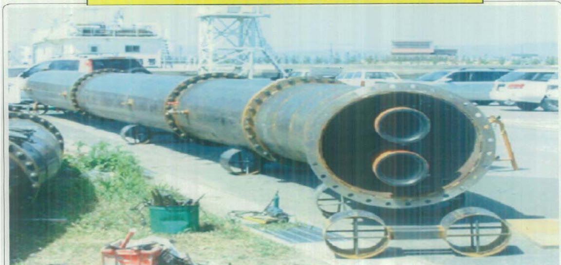
鋼管防護工法
