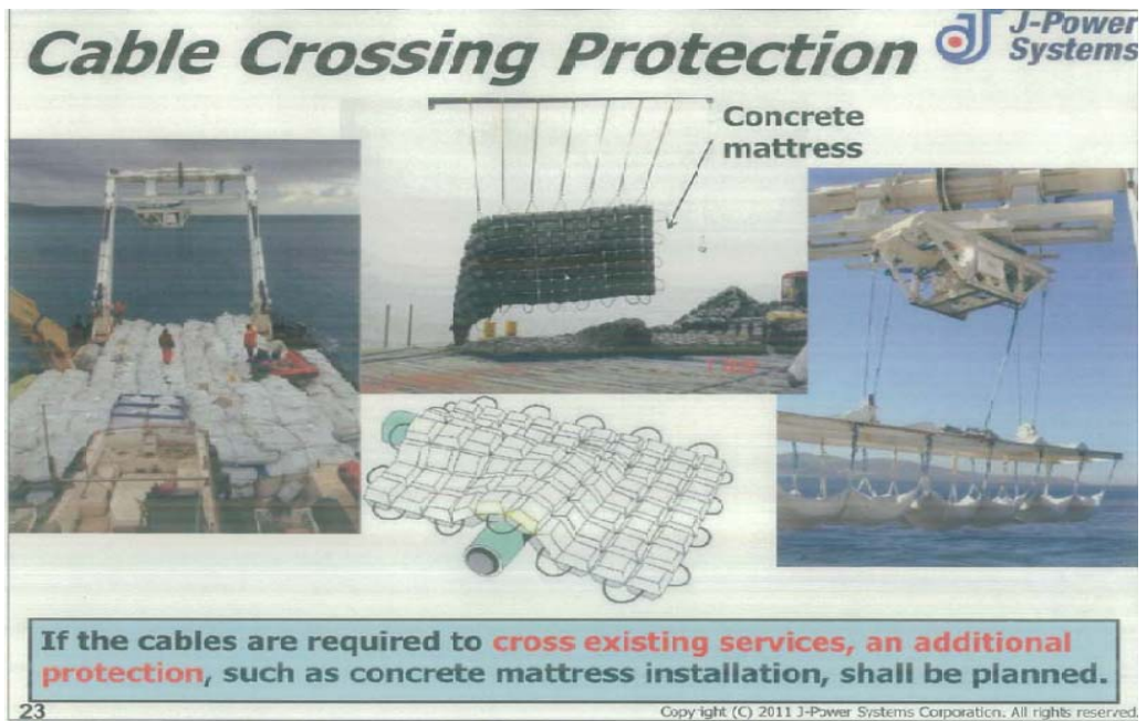
Concrete Mattress 工法
