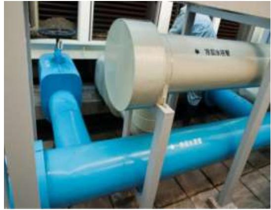
圖五：冷卻水管
