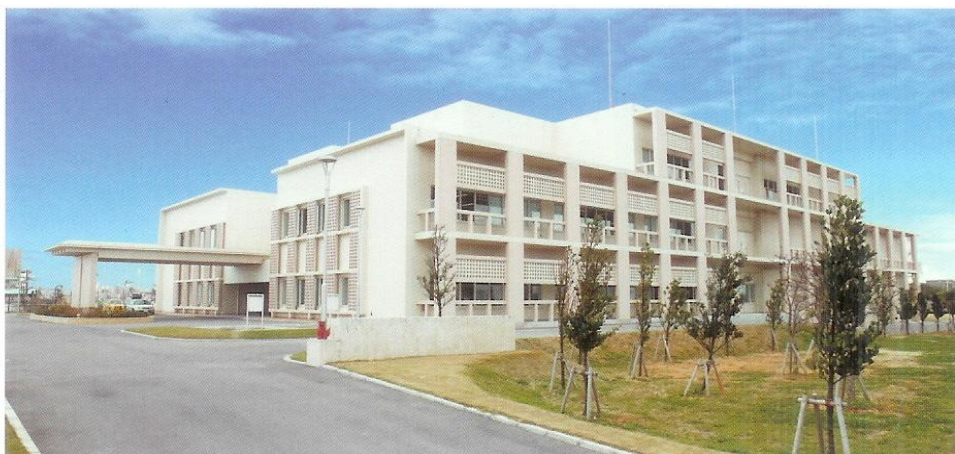
那霸航空交通管制部外觀
