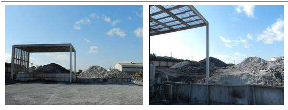
圖 18 合同製鐵廢渣堆置區(左為養化爐渣,右為還原爐渣)
