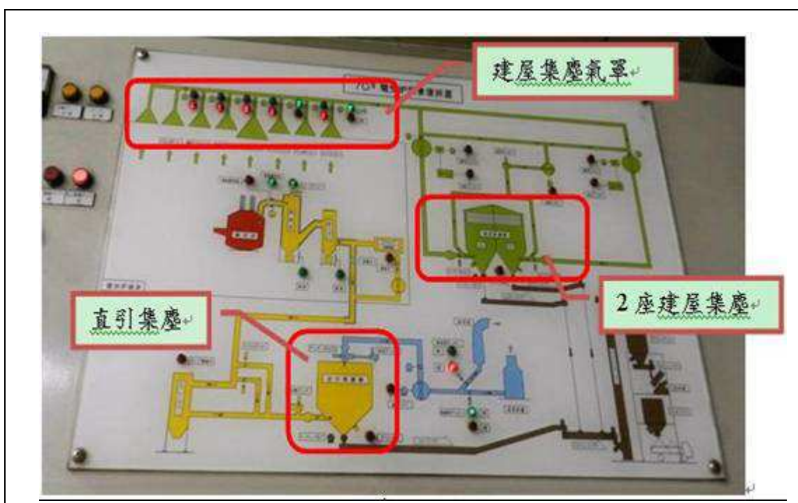
圖 11 合同製鐵集塵設備配置圖
