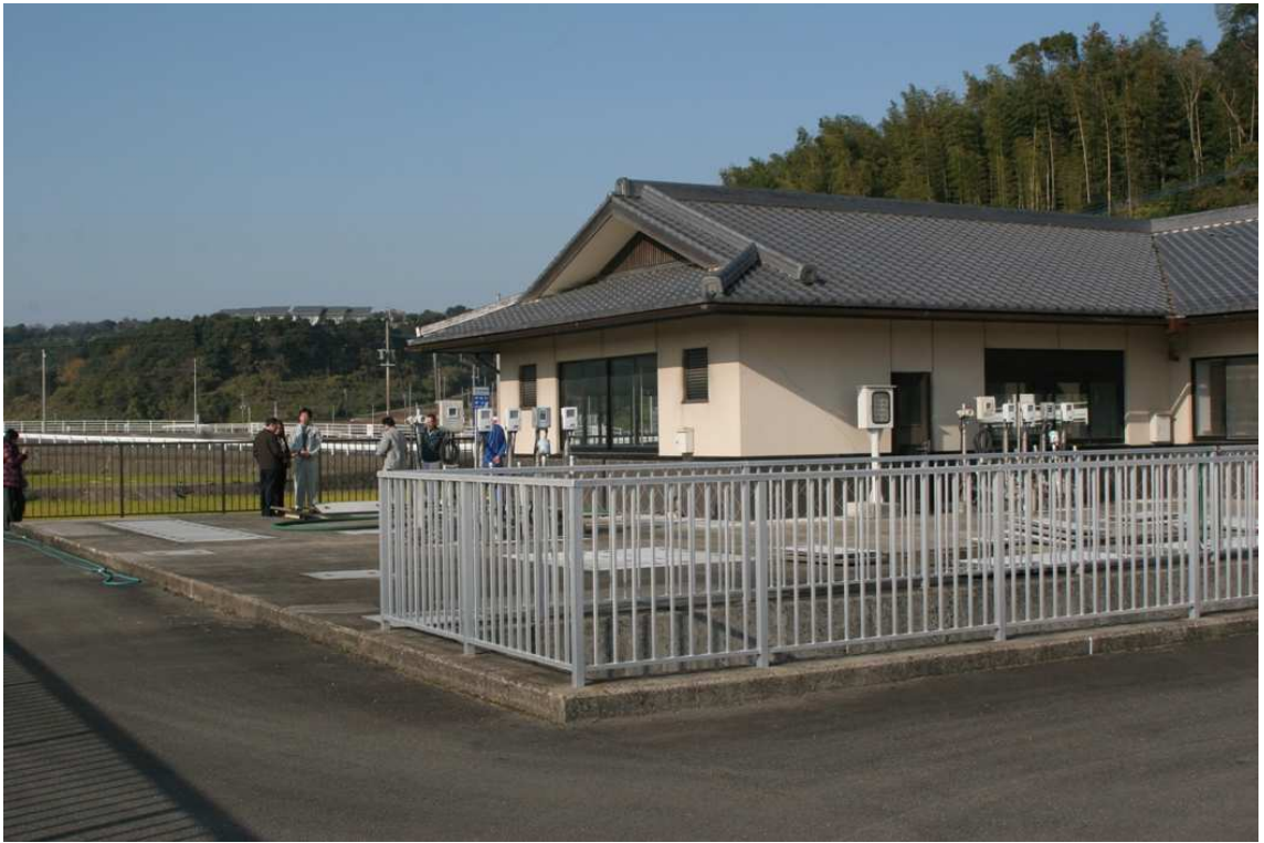
圖 10 諫早灣本明日代農業集落排水設備
