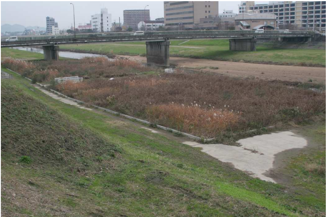
圖 2 熊添川多層次土壤淨化設施
