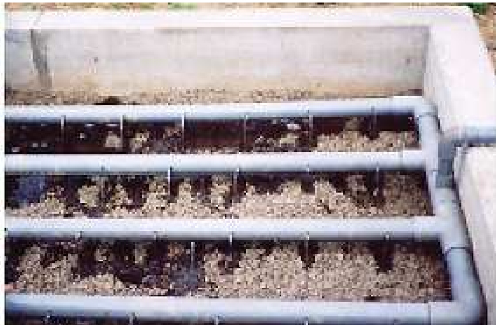
圖 17 淨水汚泥淨化設施系統構造
