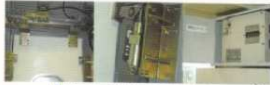
■空気式開閉装置、戸伸長装置及び戸検知制御器
