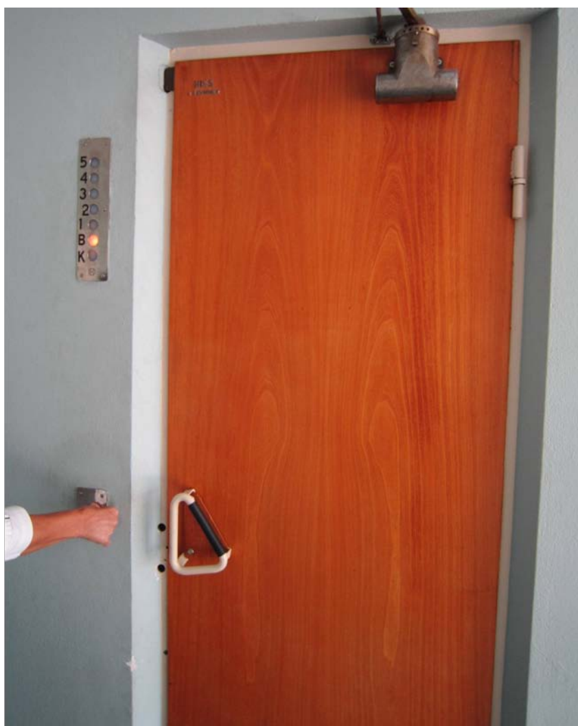
▲ 校舍內還保有早期的電梯，電梯門須手動開啟，一次僅能容納 4~5 人
