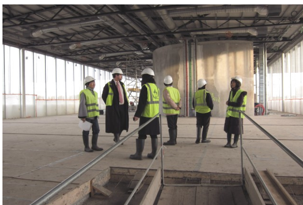
參訪施工中的隆斯羅浮宮
