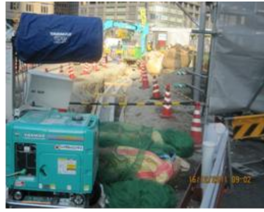
圖 4-94 東京車站丸之內南口施工
