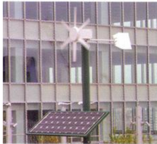
圖 4-128 大阪車站太陽廣場採用風力發電
