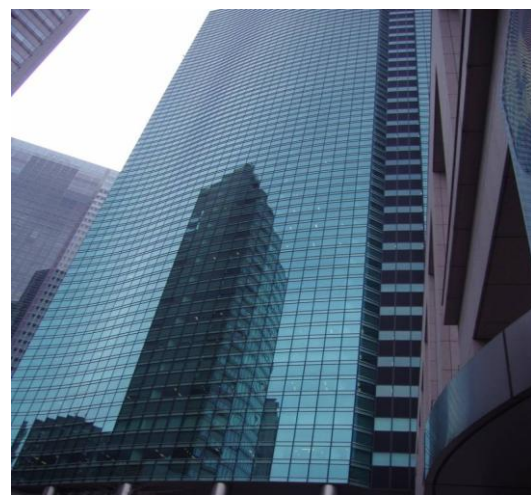
圖 8-11 舊站區重新規劃後，由 Panasonic 電工株式會社新建的大樓
