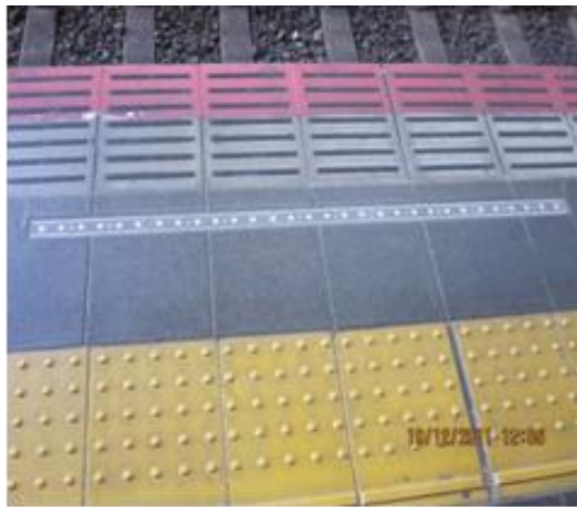
圖 4-27 大阪車站月台上之列車接近指示，採用 LED 燈。
