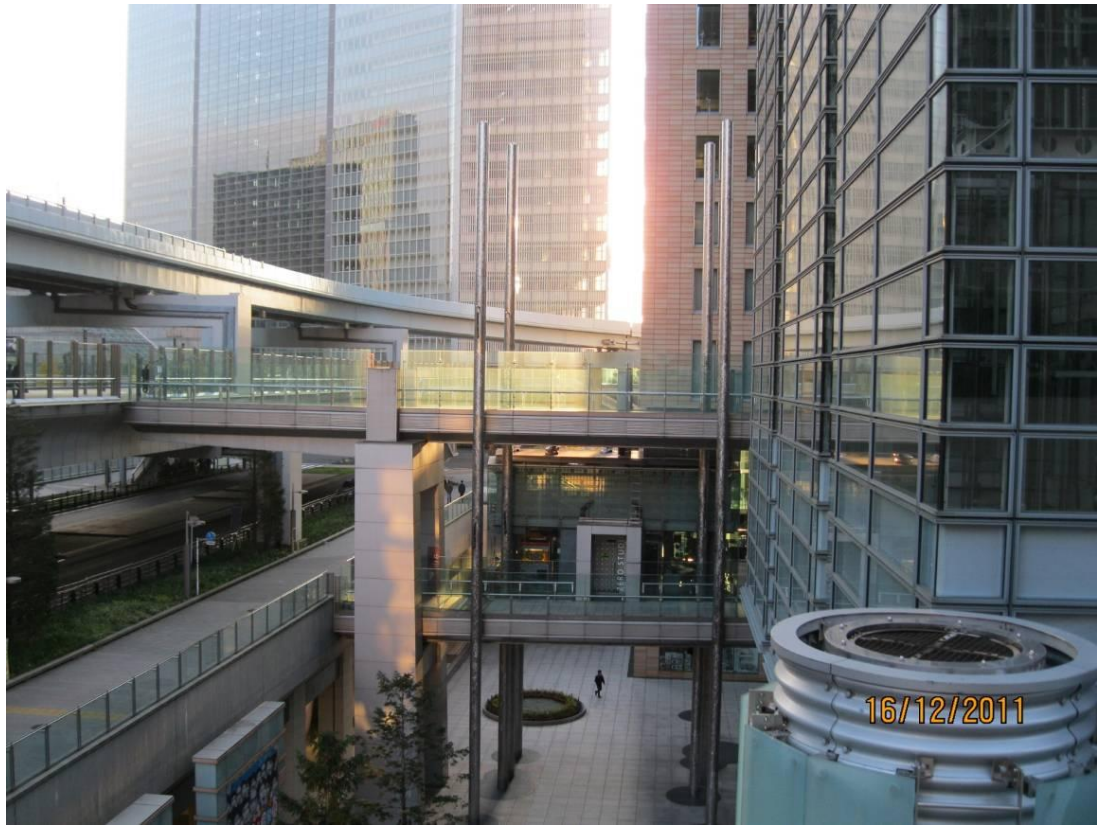
圖 8-12 汐留車站：高架為新交通系統，地下為 JR 山手線。車站穿堂層連通大樓 2 層、地面連通大樓 1 層、地下街連通大樓地下廣場。
