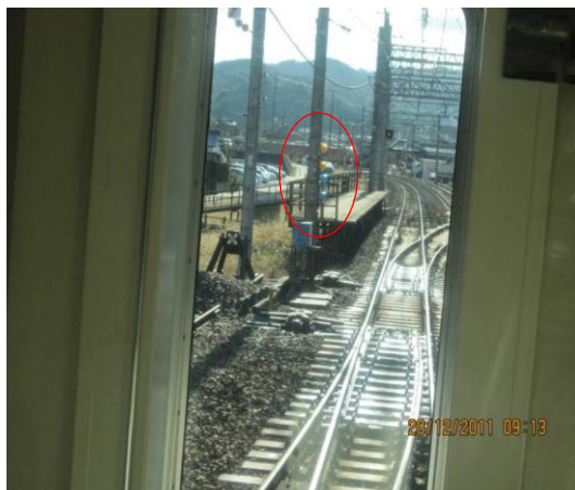
圖 4-20 名古屋本線，彎道較大之處，裝設黃色及藍色警示燈(分上、下行，用不同顏色警示)，警告維護路線之工作人員，列車接近應注意安全。
