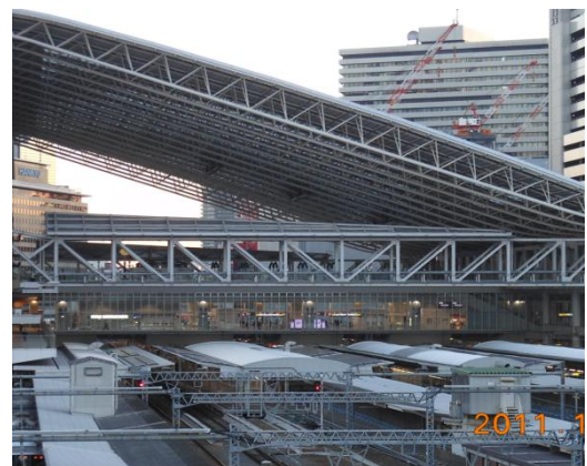
圖 3-50 大阪站橋上站及頂棚西向立面外觀
