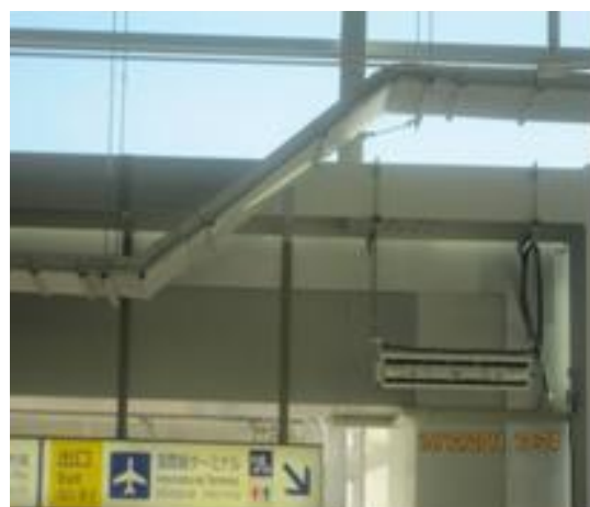
圖 4-16 電纜架(Cable tray)之配置
