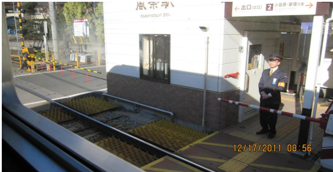
圖 6-4 當搭乘列車由小田原進入湯本箱根時,經過一個小站,僅有 2 個岸壁式的月台,沒有跨站天橋或地下道,僅有上圖站務人員前方的迷你平交道讓月台的旅客穿越進出車站,另車站也大約只有 3 m 2 ,真是精緻又有特色,可能是私鐵的關係爲了節省成本而設的車站吧!在國內行車量較少的支線如有機會改建,當可參考此設計規模融入地方特色。
