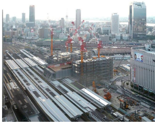
圖 3-25 2008 年 10 月橋上站南北自由通道鋼骨工程施工
