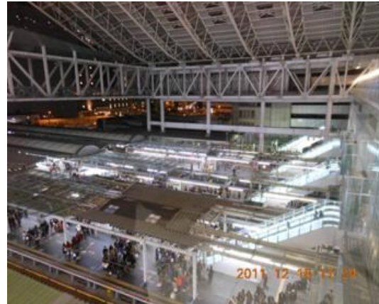
圖 3-20 原有月台增設電扶梯與橋上站聯通
