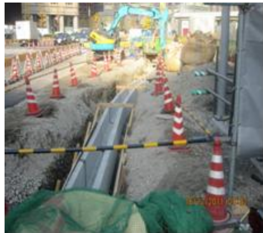
圖 4-22 東京車站丸之內南口施工
