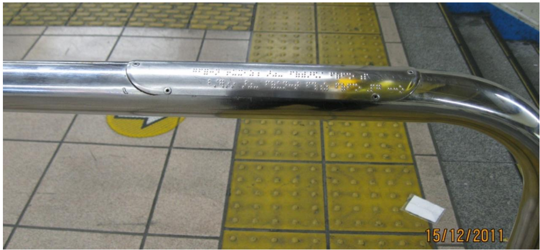
圖 4-14 各車站之把手在路線轉彎或動線變化處均有設置點字說明,圖為秋葉原車站樓梯扶手點字。
