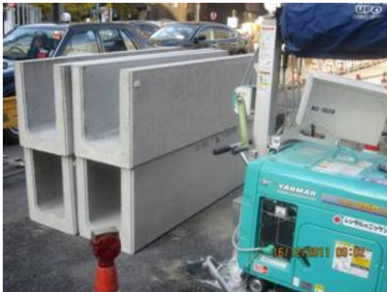
圖 4-93 東京車站丸之內南口施工
