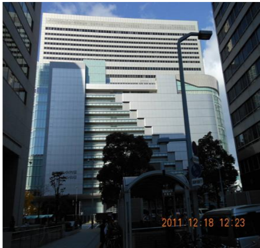
圖 3-47 大阪站現況南向立面外觀
