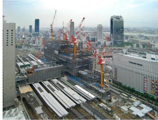
圖 3-26 2009 年 5 月橋上站南北自由通道鋼構工程連通
