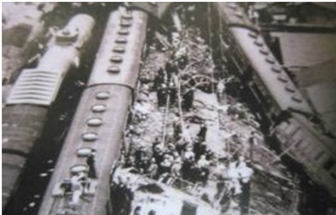
圖 5-18 1962/5/3 三河島事故，列車冒進閉塞號出軌及引導旅客錯誤，造成 160 死、296 傷，引發 ATS 系統改善。
