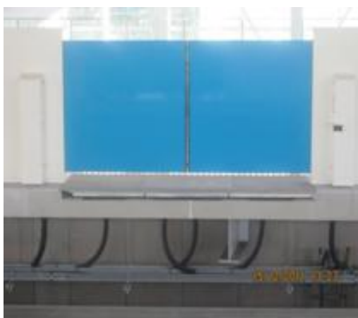
圖 4-15 JR 東日本山手線各站電纜從水泥線槽引進配線箱之情形
