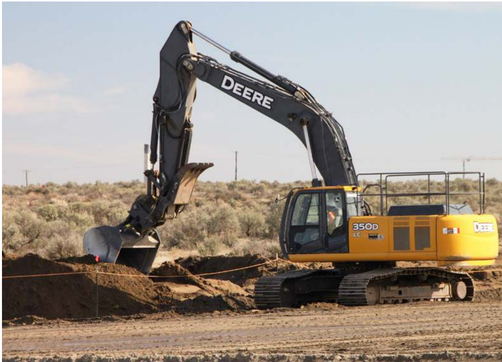
圖 2.3 CH2M Hill 公司在 Hanford Site 內的 BC Control Area 做土壤復育
