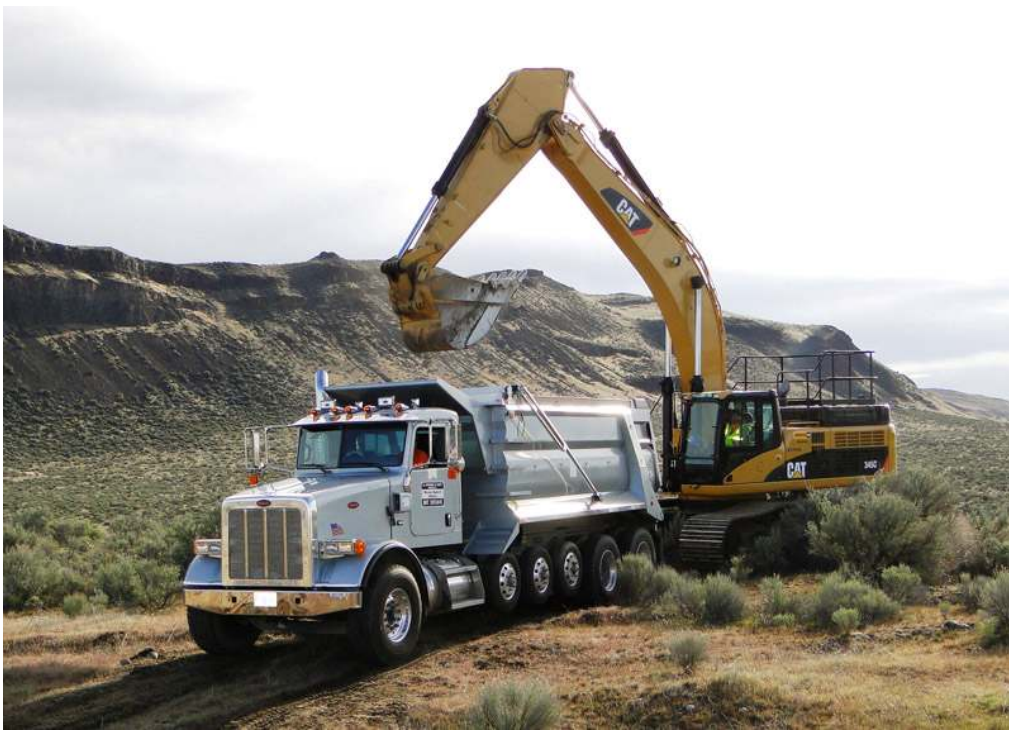
圖 2.2 CH2M Hill 公司針對 Hanford Site 內 600-40 waste site 的 Remediation
