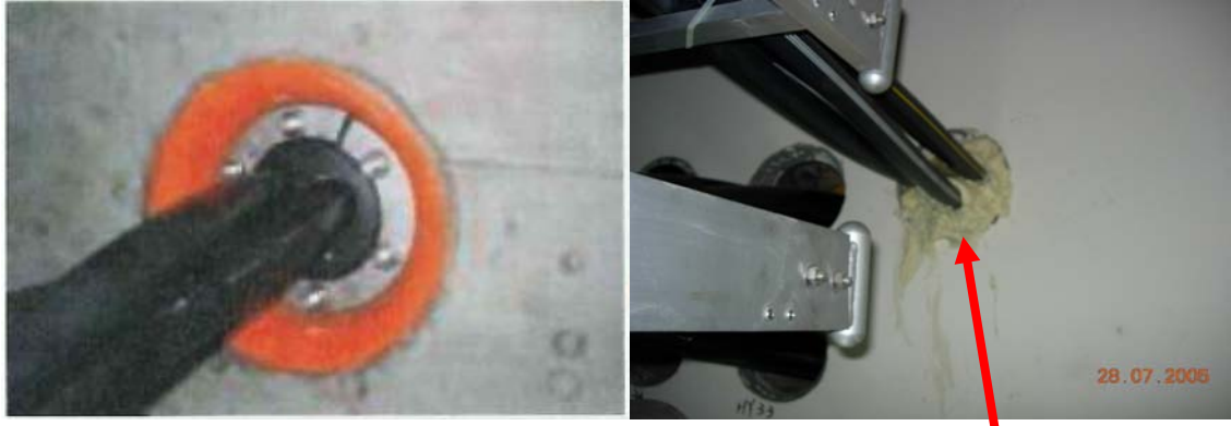
中電之配電室內管路防水
