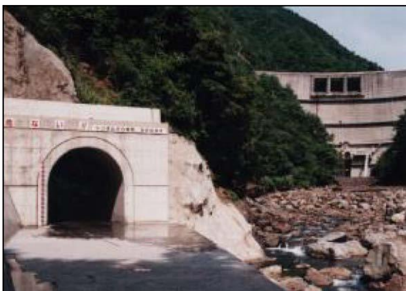
圖 4.13 旭壩繞道排砂系統出水口照片
