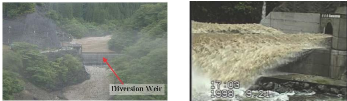
圖 4.23 1998 年 7 號颱風來襲，旭水庫及繞道排砂系統出水口照片
