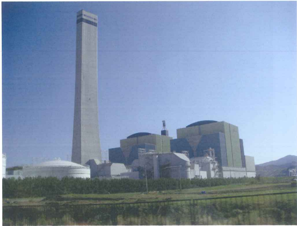
圖 6：橘灣電廠廠房照片
