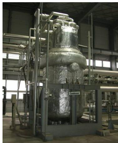
圖 9 溫差發電冷凝器
