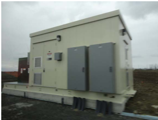
加拿大安大略省建造中太陽光電站(共 29MW)，使用貨櫃式整合兩台 Inverter 及 Switchgear 及 Scada、控制器等，縮短施工及試運轉期間
