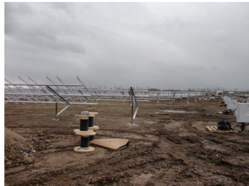
加拿大安大略省建造中太陽光電站(共 29MW)，使用貨櫃式整合兩台 Inverter 及 Switchgear 及 Scada、控制器等，縮短施工及試運轉期間
