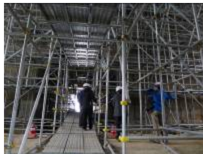
圖 36：修復工程一隅
