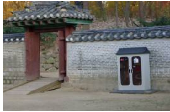
圖 12：宮內設置之消防栓(宗廟)
