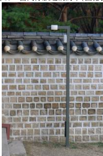
圖 17：宮內設置紅外線闖入偵測(宗廟)
