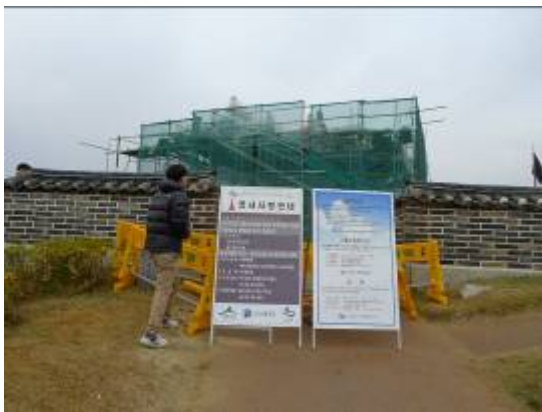
圖 61：部分角樓修復中
