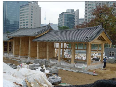
圖 24：德壽宮復建工程情形
