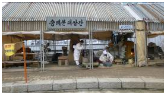
圖 37：修復工程旁之金屬構件製作所
