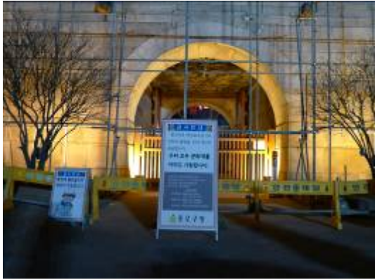
圖 27：入口處之施工標示
