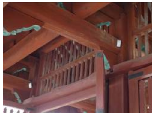
圖 16：宮內設置之入侵偵測器(宗廟)
