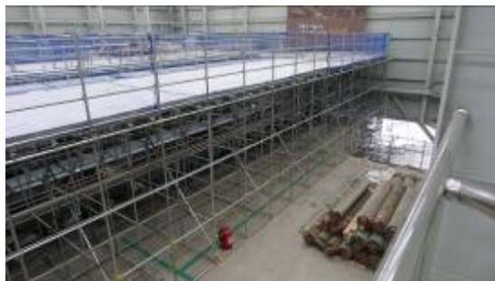
圖 35：修復工程一隅
