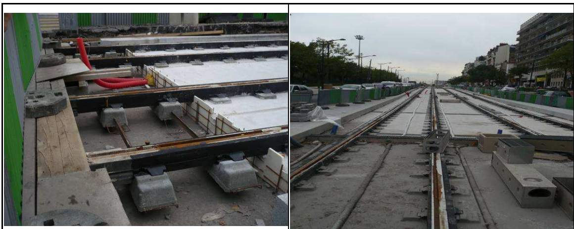
圖 3.6-10 巴黎 T3 線延伸段軌道鋪設 2
