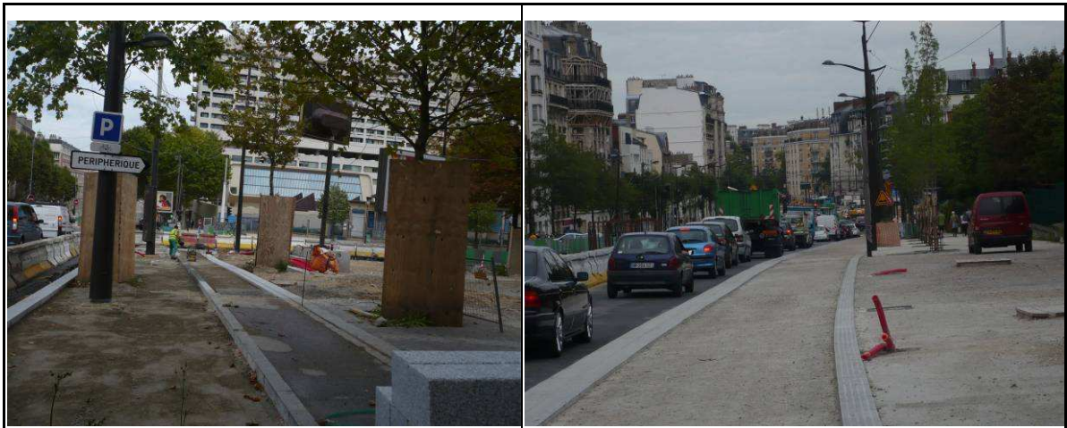
圖 3.6-7 巴黎 T3 線延伸段施工中之人行道
