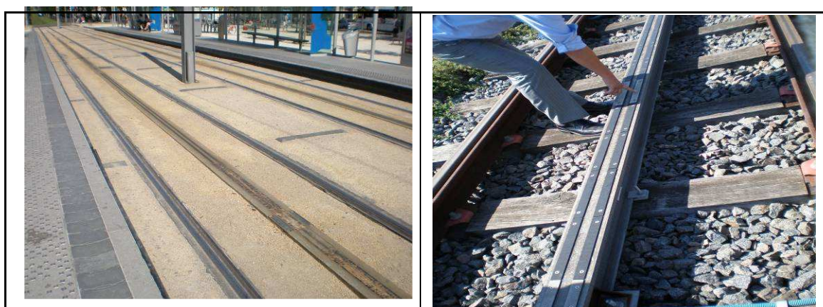
圖 3.3-4 波爾多 APS 地面供電系統軌
