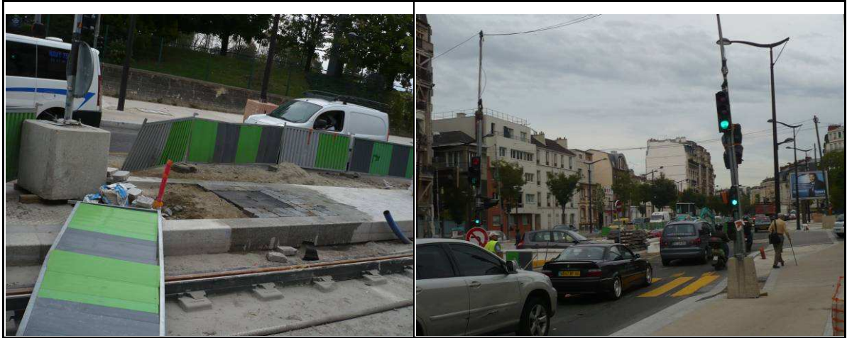
圖 3.6-8 巴黎 T3 線延伸段施工中之月台
