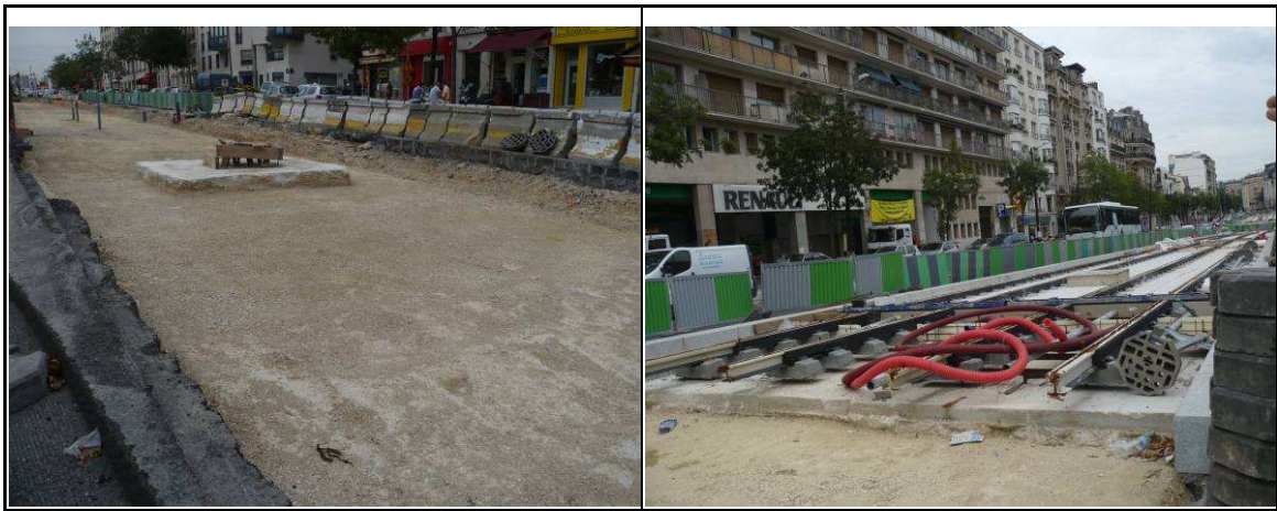
圖 3.6-9 巴黎 T3 線延伸段軌道鋪設
