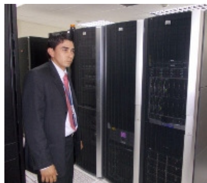
審計署電腦主機機房
