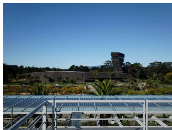
圖27 科學館太陽能板照片
